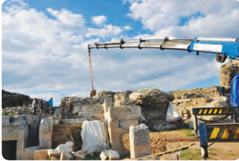
Taş kaldırma çalışmaları
